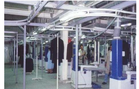
Zone de finition - repassage
