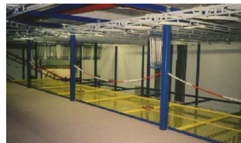
Passerelle de traitement dynamique
