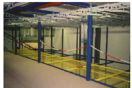
Passerelle de traitement dynamique
